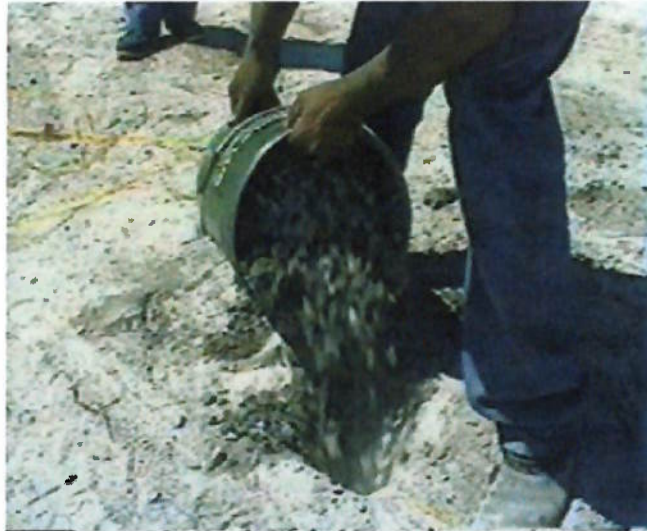
Figura 22 - Carregamento do tampão com "Pedra 1"
