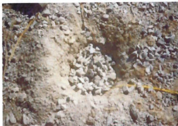
Figura 21 - Detalhe do tampão de “Pedra 1” no furo
