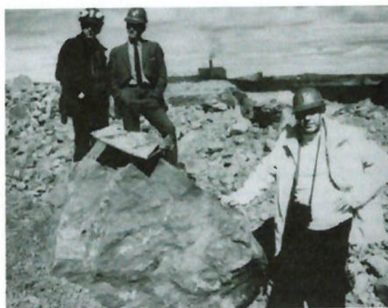
Figura 20 - Mataco de 3 toneladas arremessado a 300 metros em mina a céu aberto
